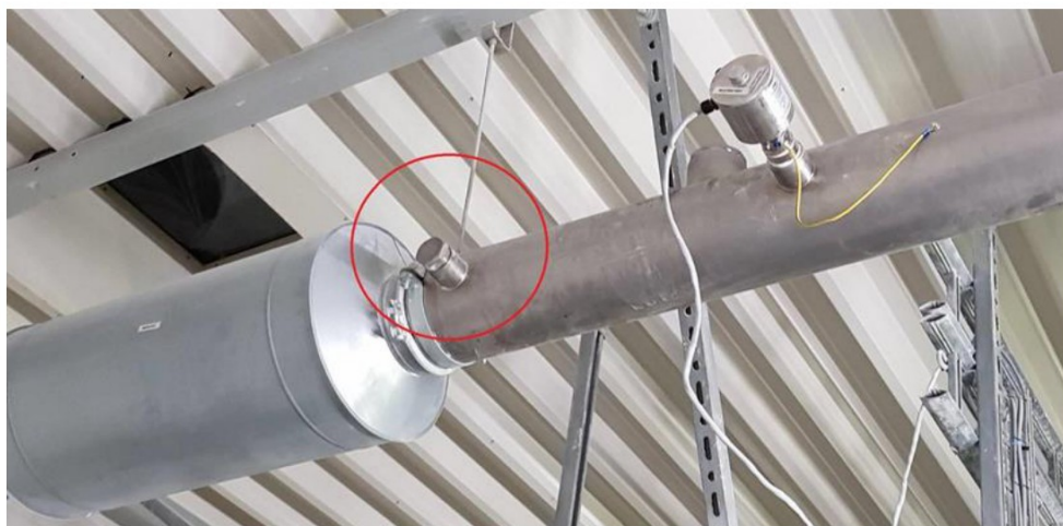
Afbelding 4 Afvoerbuis met monsteropening (rood omcirkeld) en rechts daarvan de zakbreukbewakingssensor
